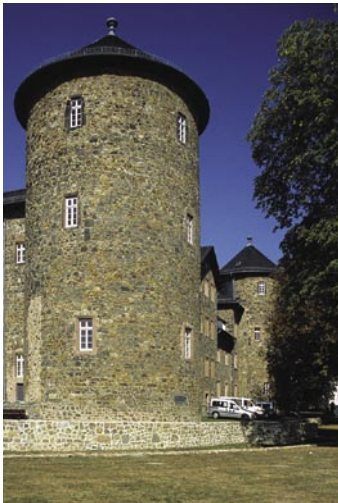
Batterietürme am östlichen Stadtgraben, ca. 1475 erbaut
